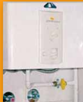
Conexión con tubería rígida
